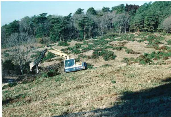
写真-3 重機による抜根、整地、茨城県林業技術センター提供。
